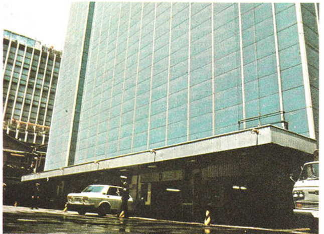
နေရာ ပိုထွက်လိုသဖြင့် အချို့ အထပ်များများပါသော ကားထား အဆောက်အအုံတွင် ဓာတ်လှေကားဖြင့် တင်ပို့သည်။
