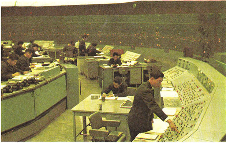
‘ဗဟိုထိန်းကွပ်ဌာန’ သည် ရထားစနစ်၏ ဦးနှောက်ကဲ့သို့ အချက်အချာ ဖြစ်၏။ လိုင်းပေါ်ရှိ ရထားသွားလာမှု အားလုံးကို ဤဌာနမှ ထိန်းကွပ်သည်။ ကိုရိုယာများကို ကောင်းစွာမြင်နိုင်ရန်နှင့် ထိန်းကွပ်နိုင်ရန် ယာဉ်မောင်းခန်း ကို စီစဉ်ထားသည်။
