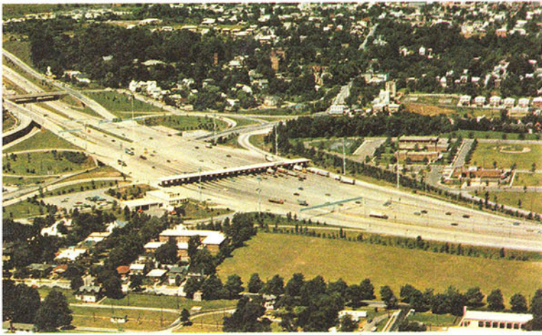
အခွန်ဆောင်ရသည့် လမ်းမပေါ်ရှိ အခွန်ကောက်ခန်း
